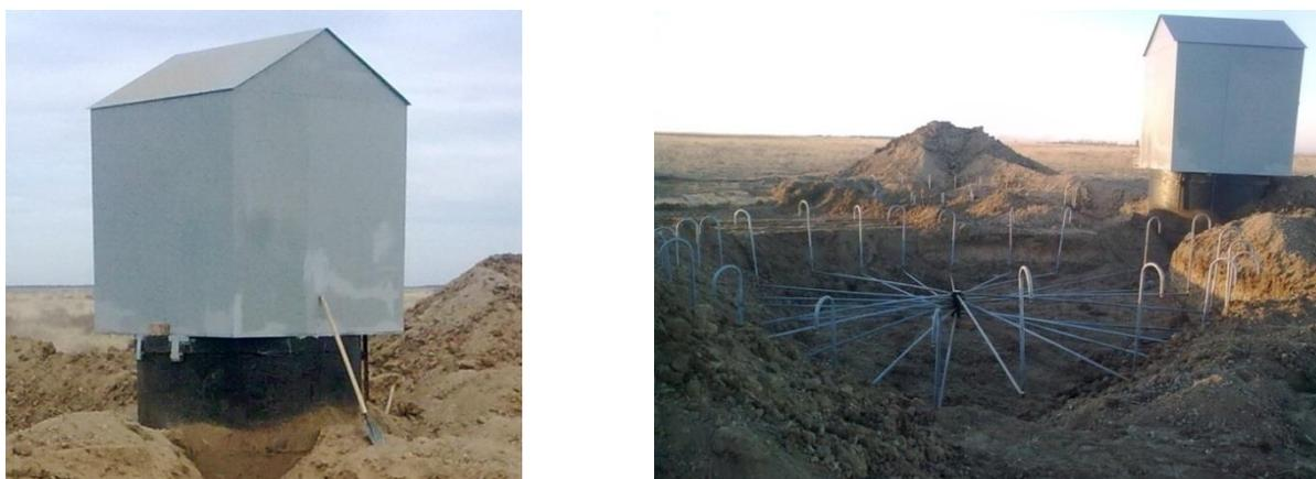
*Рисунок 5. Сборка подземной и наземной частей приборных сооружений (слева), монтаж радиально-лучевых систем сбора акустических сигналов (справа)*
