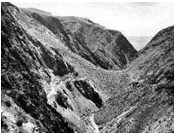
Рисунок 1. Взрыво-набросная плотина на р. Учтерек.
