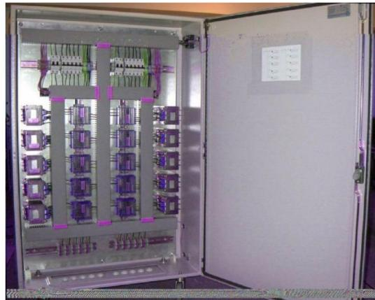
Рисунок 7. Сейсмическая станция AS057-Боровое. Модуль питания, установленный в Центре сбора/передачи информации и AS44-Каппанг (Индонезия), а также на инфразвуковой группе IS31-Актюбинск (Казахстан).
