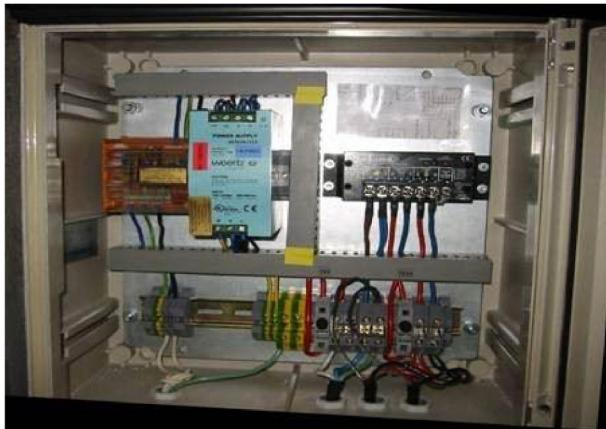
Рисунок 6. Сейсмическая станция AS057-Боровое. Модуль питания выносного пункта
