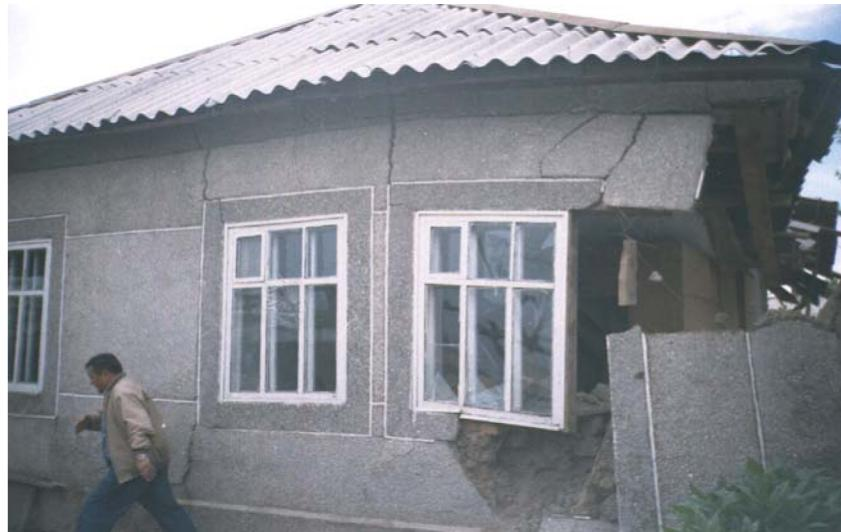
*Рис. 2.* Обрушение угловой части жилого дома на станции Луговая
