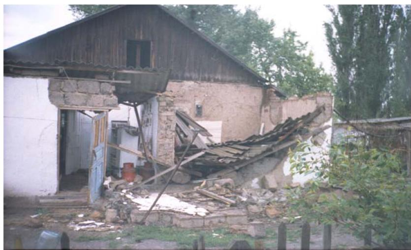
*Рис. 4.* Обрушение стены дома на станции Луговая
