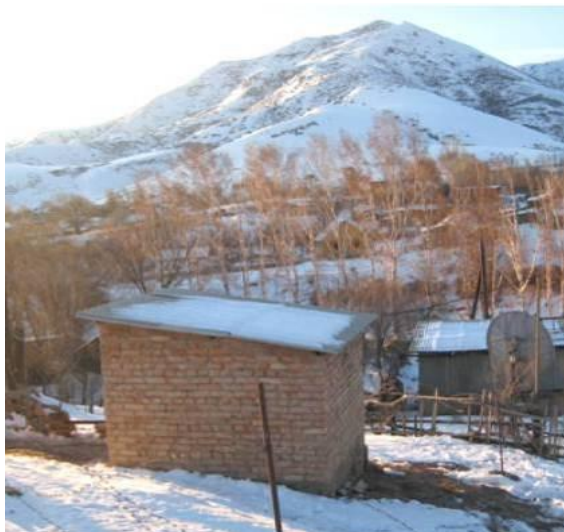
а – приборное сооружение
