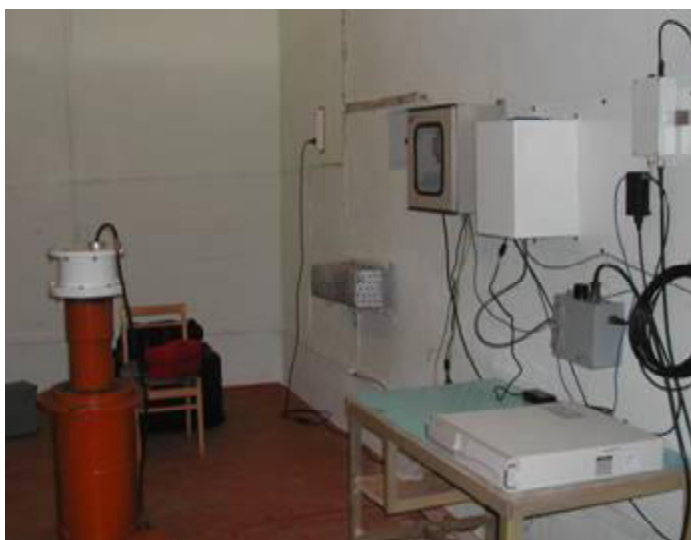
Рисунок 5. Станция AS059-Актюбинск: приборное сооружение (слева - оголовок скважины, в которой установлен сейсмоприемник, справа - электронная часть оборудования); монтаж антенны
