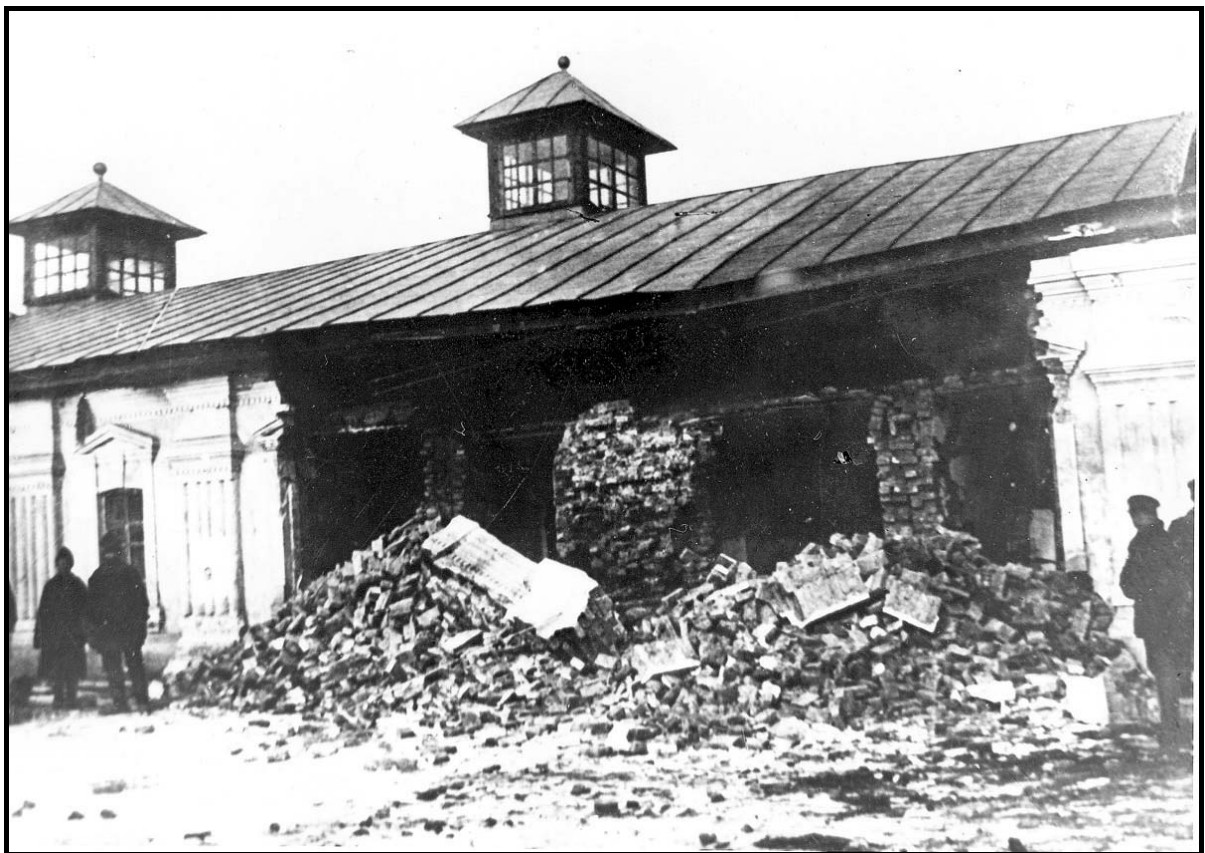
Рис.2.3.4а Баня Жиленкова. Обрушение части здания.
