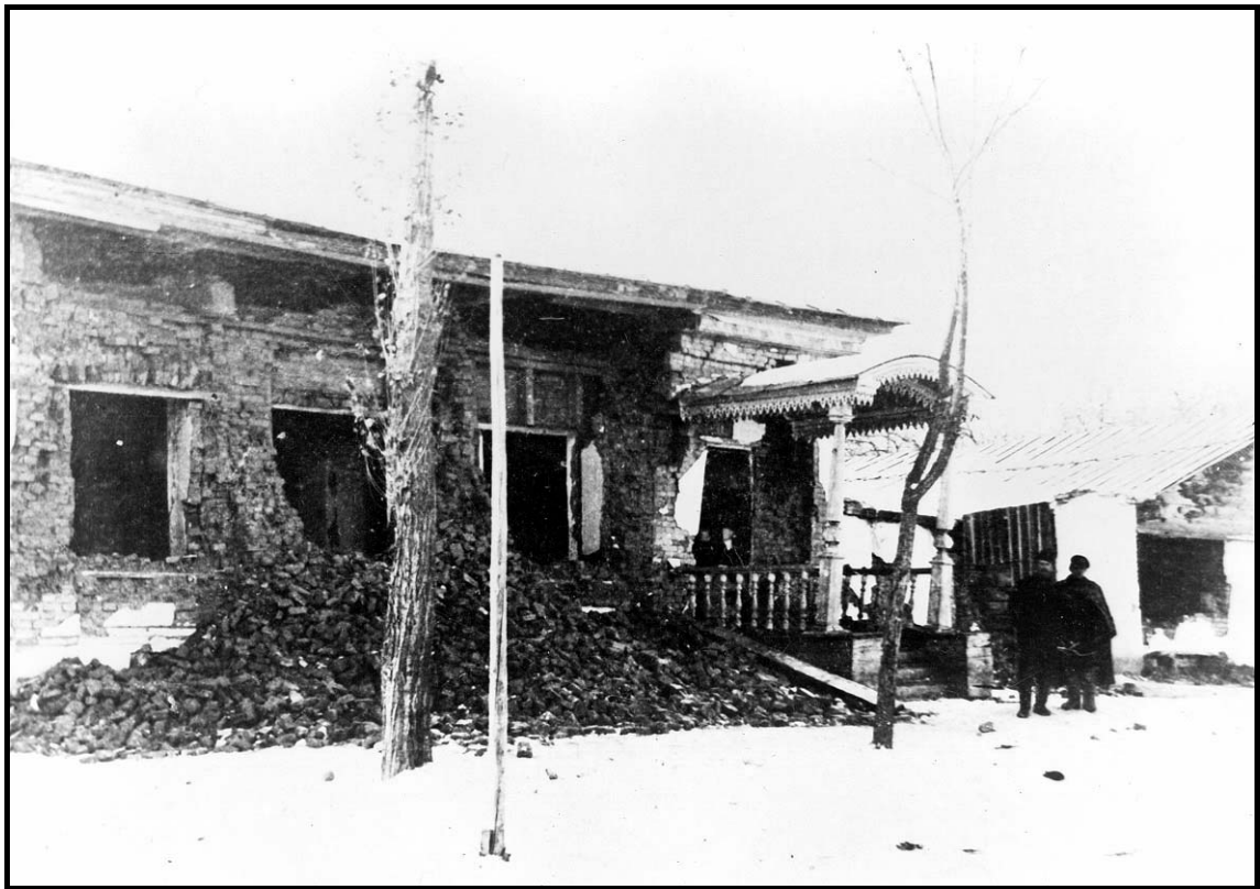
Рис.2.3.4б Обрушение наружной стены жилого
