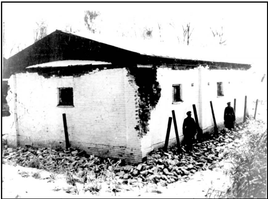
Рис.2.3.4в Здание Военных казарм после землетрясения
