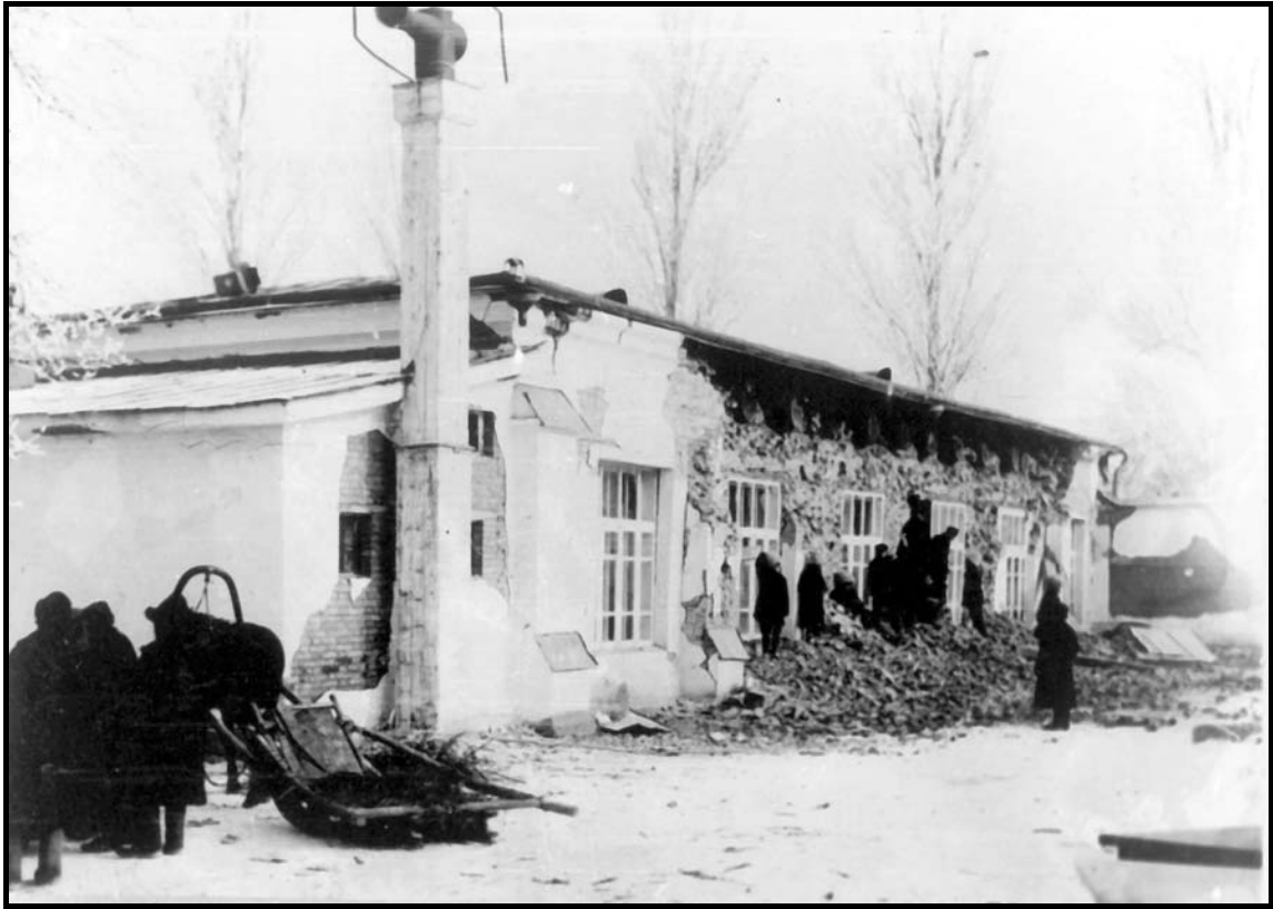
Рис.2.3.4 г Общий вид стены поврежденного кирпичного здания.
