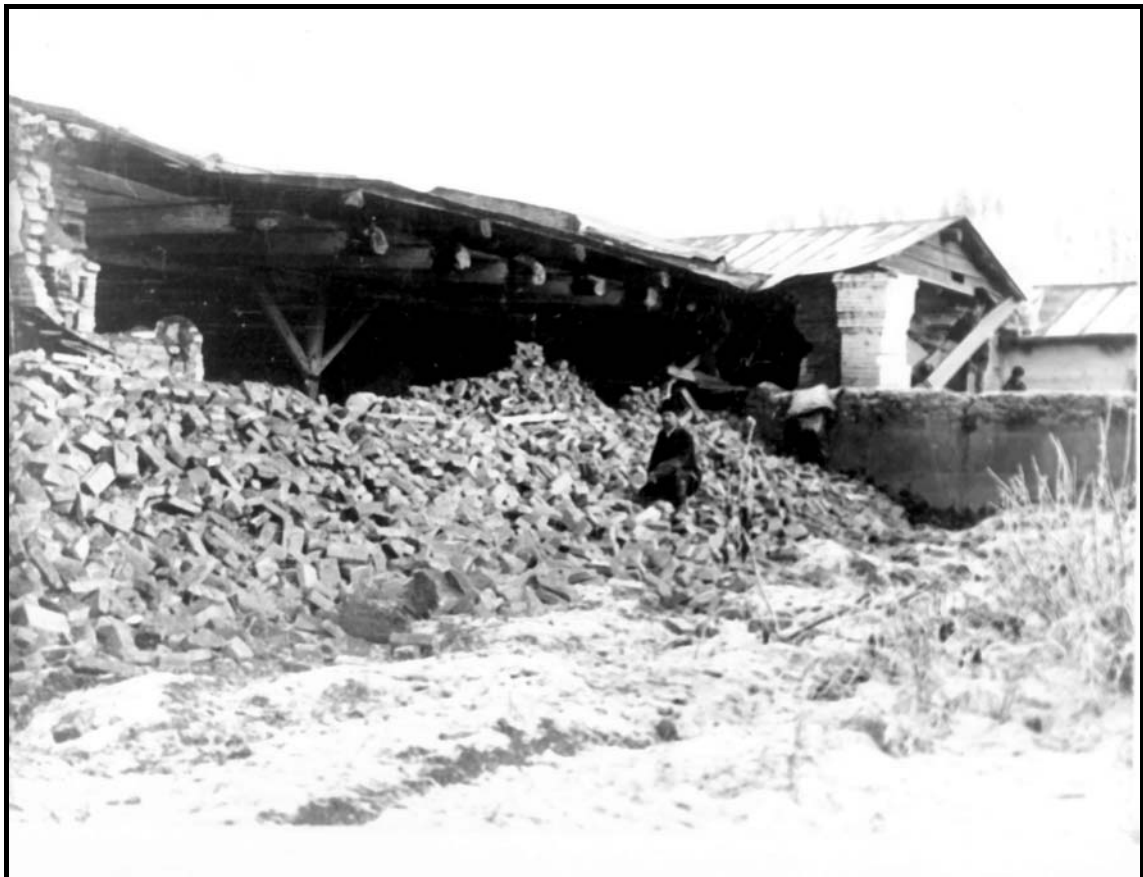
Рис.2.3.3б Склады после землетрясения
