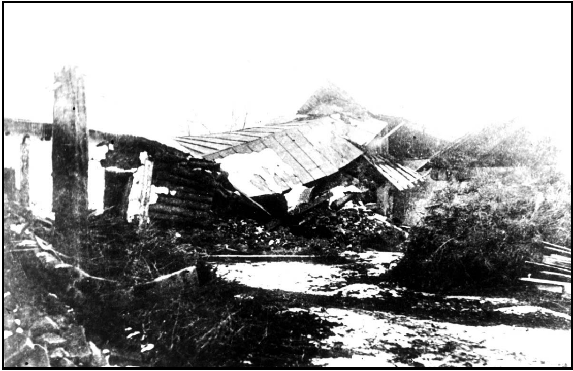
Рис.2.3.3а Обрушившийся жилой дом
