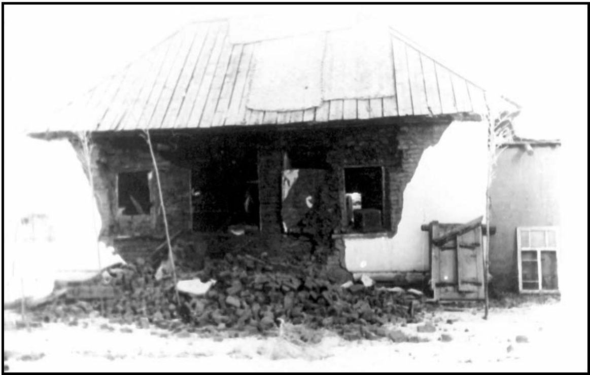
Рис.2.3.3в Обрушившийся кирпичный дом
