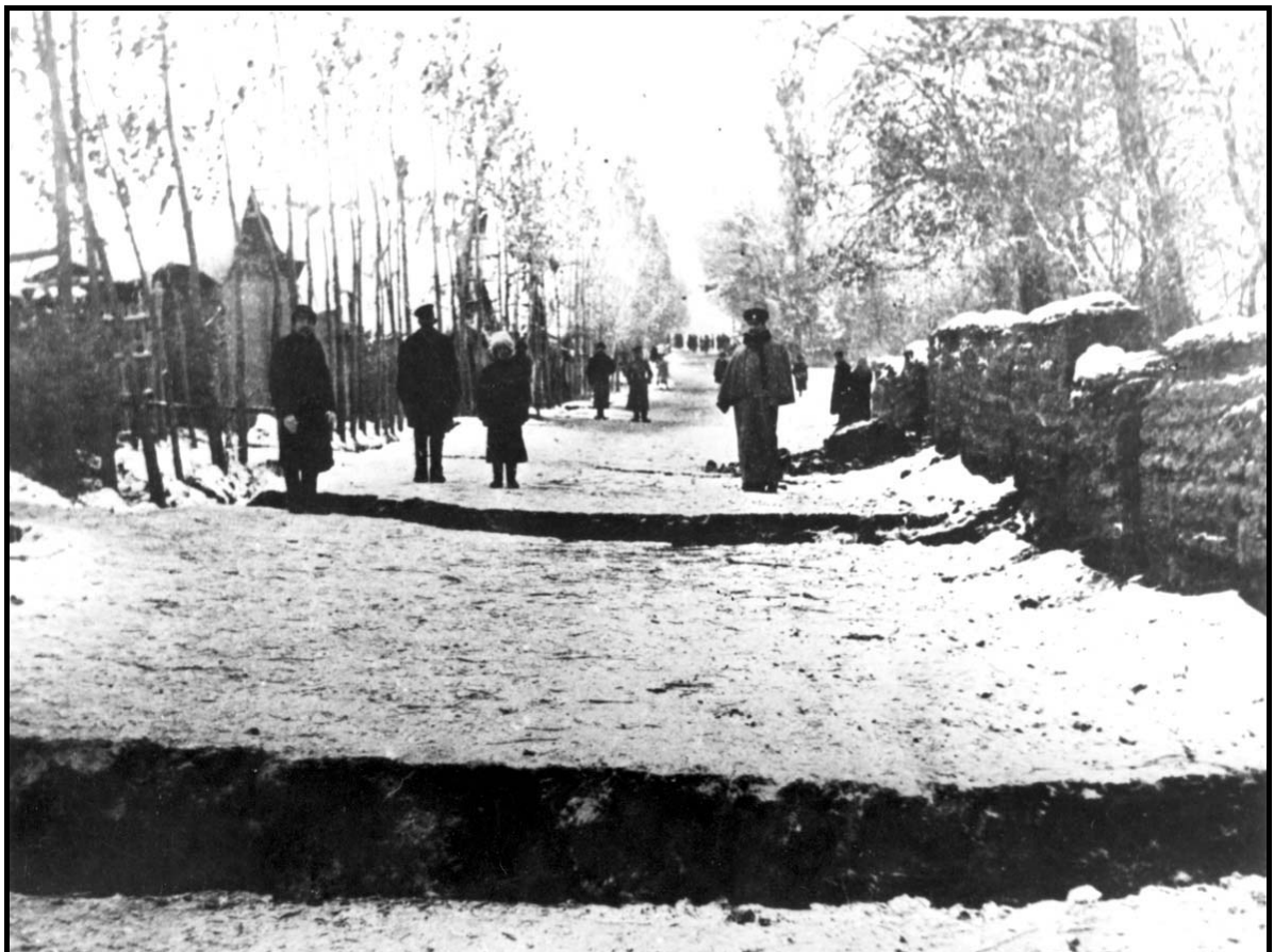
Рис.2.3.11 а, б Широкие трещины в грунте
