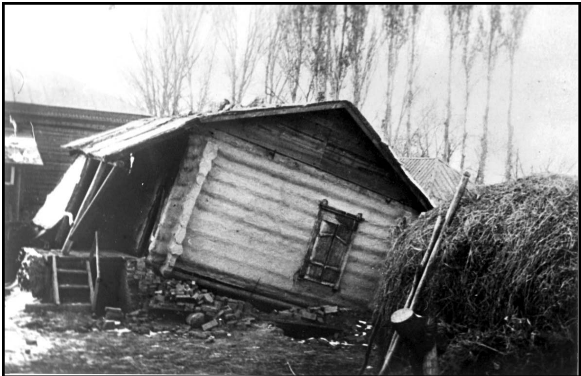
Рис.2.3.5 Перекося деревянного дома (сруба) в результате землетрясения
