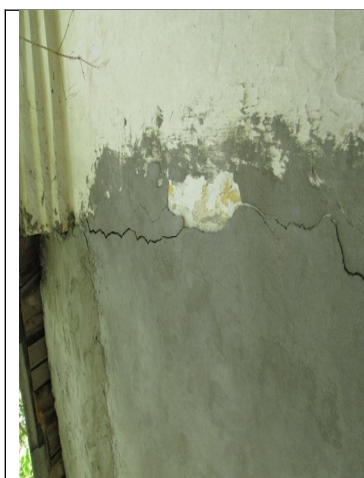
Рис. 9. Свежие трещины между помещениями после ремонта на стенах административного здания карьера
